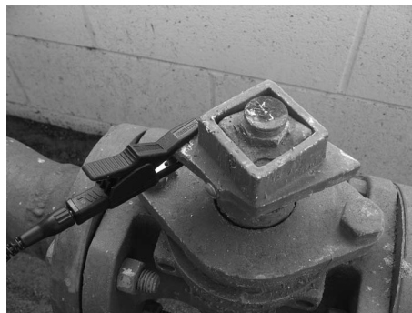
Рис. 7: Соединение прибора ST-305 с магистралью
